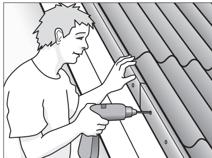
Fastgør løse inddækninger.
